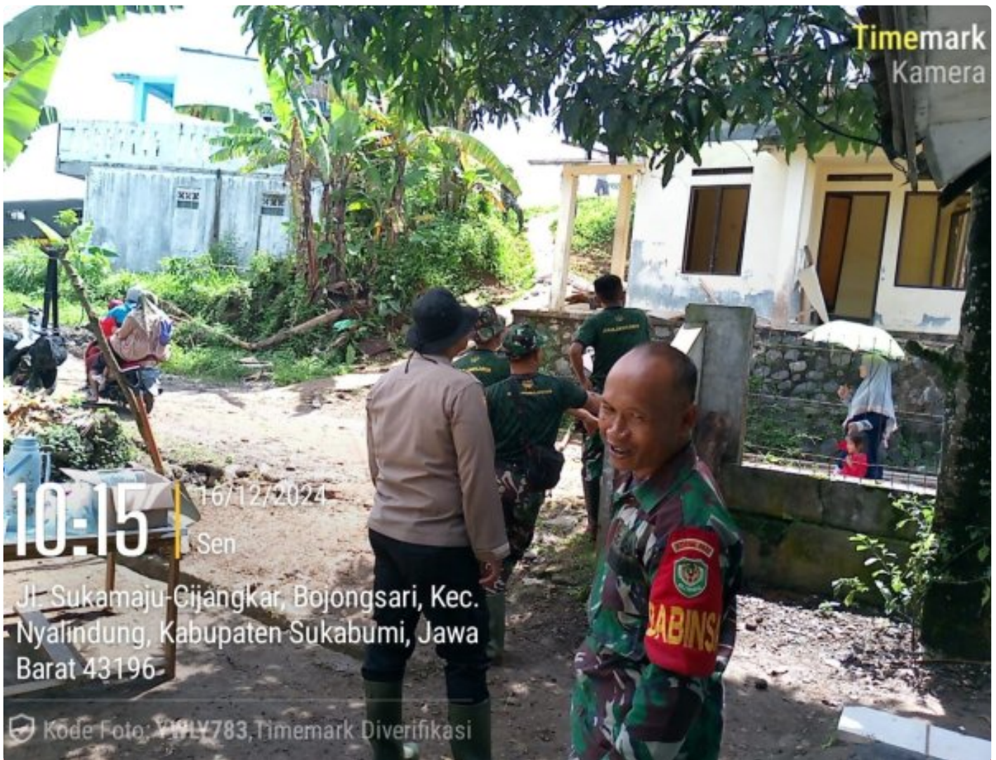
Tanggapan Cepat Polsek Nyalindung Polres Sukabumi Pasca Bencana Alam, Warga Desa Bojongsari Diberikan Bantuan Material Bangunan
